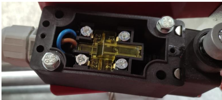
Abb. 37 Anschluss Endschalter
