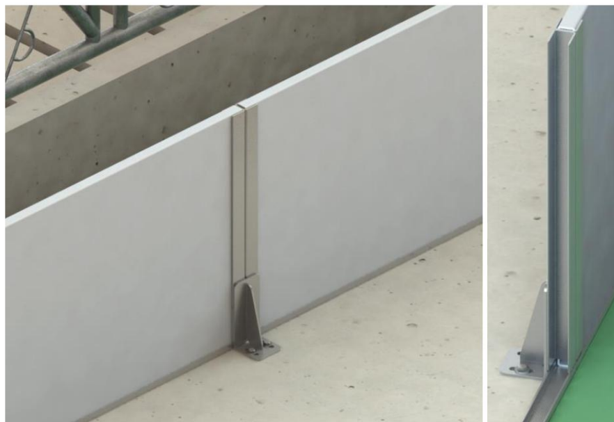
Slika 13 Vgrajen modularni stenski sistem
